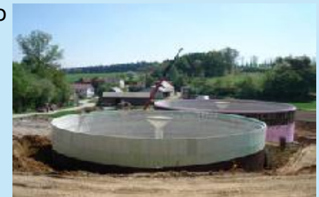
Здійснення будівельних та монтажних робіт
